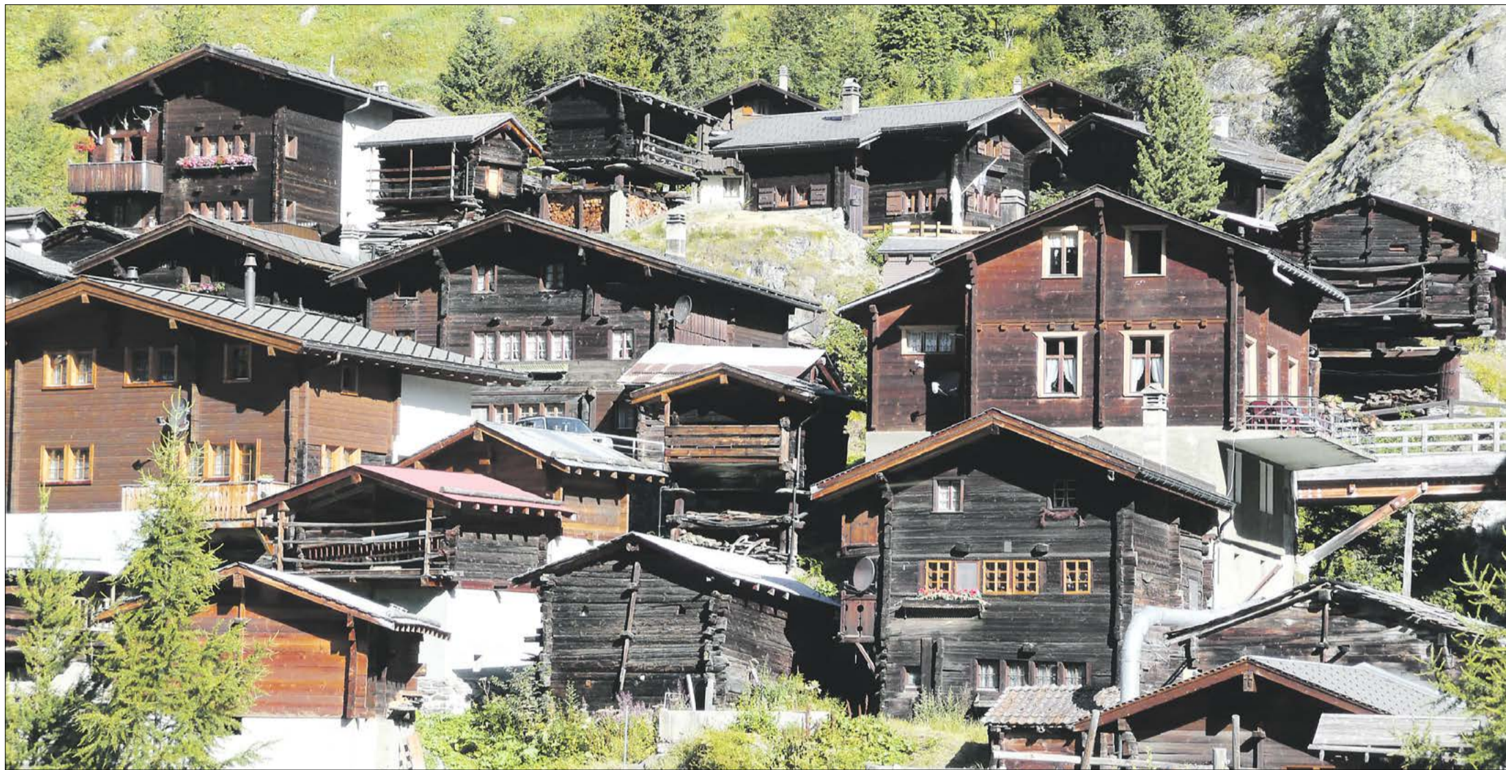
Gesamtansicht von Blatten im Lötschental als Beispiel, wie Ställe ins Ortsbild eingepasst sind, also als «ortsbildprägend» erhalten werden müssen.
